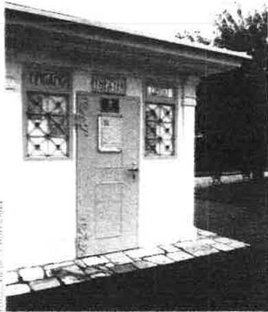
Blick vom Park zum kleinen Theatergebäude
